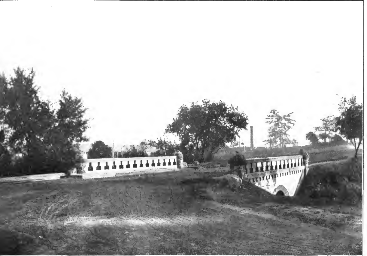
Ein Blick auf die neue städtische Mlee-Anlage. (Concrete Bridge on "Driveway".)
